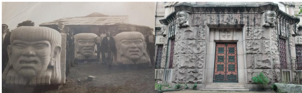
Figuras 3 e 4 – Mísulas antropomórficas na oficina de cantaria e instaladas na base das absides laterais.
