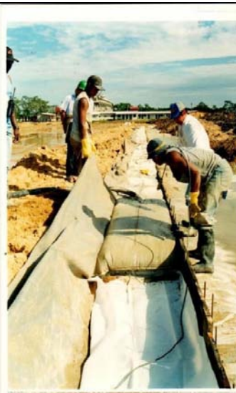
Imagem 2 – Canteiro de obras
